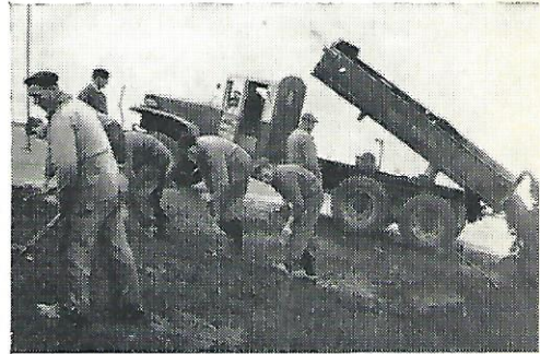
Asfalt dient voor de afwerking van de dijk. Op de achtergrond een asfalteringsinstallatie en tankwagens (boven). Het asfalt wordt uitgestreken (beneden).
