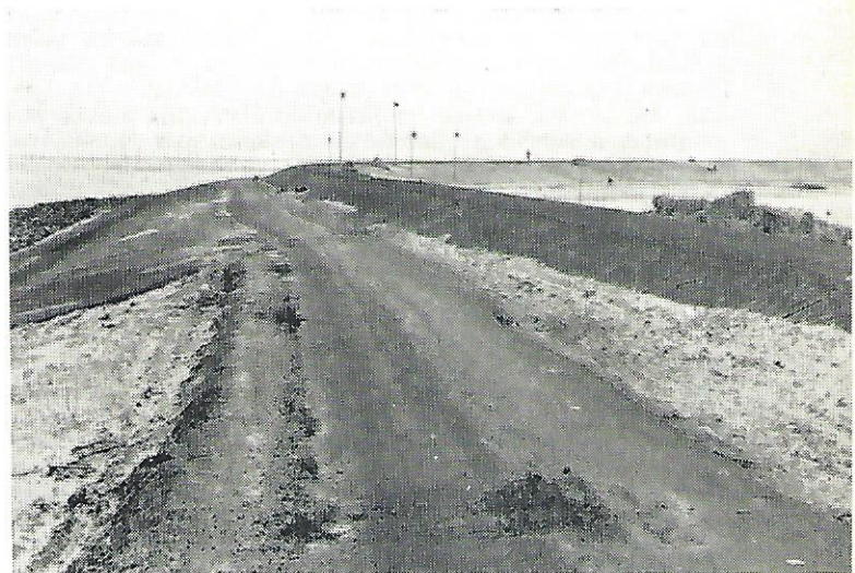
Nu moeten zand en water nog uit de badkuip worden verwijderd waarna men kan beginnen met de volgende fase: het bouwen van de sluisen.
